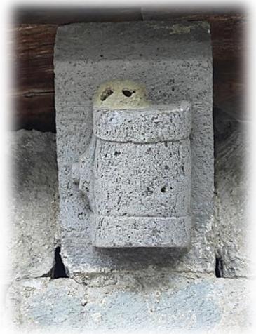
Tonneau, église de Jou-sous Monjou (Cantal)
