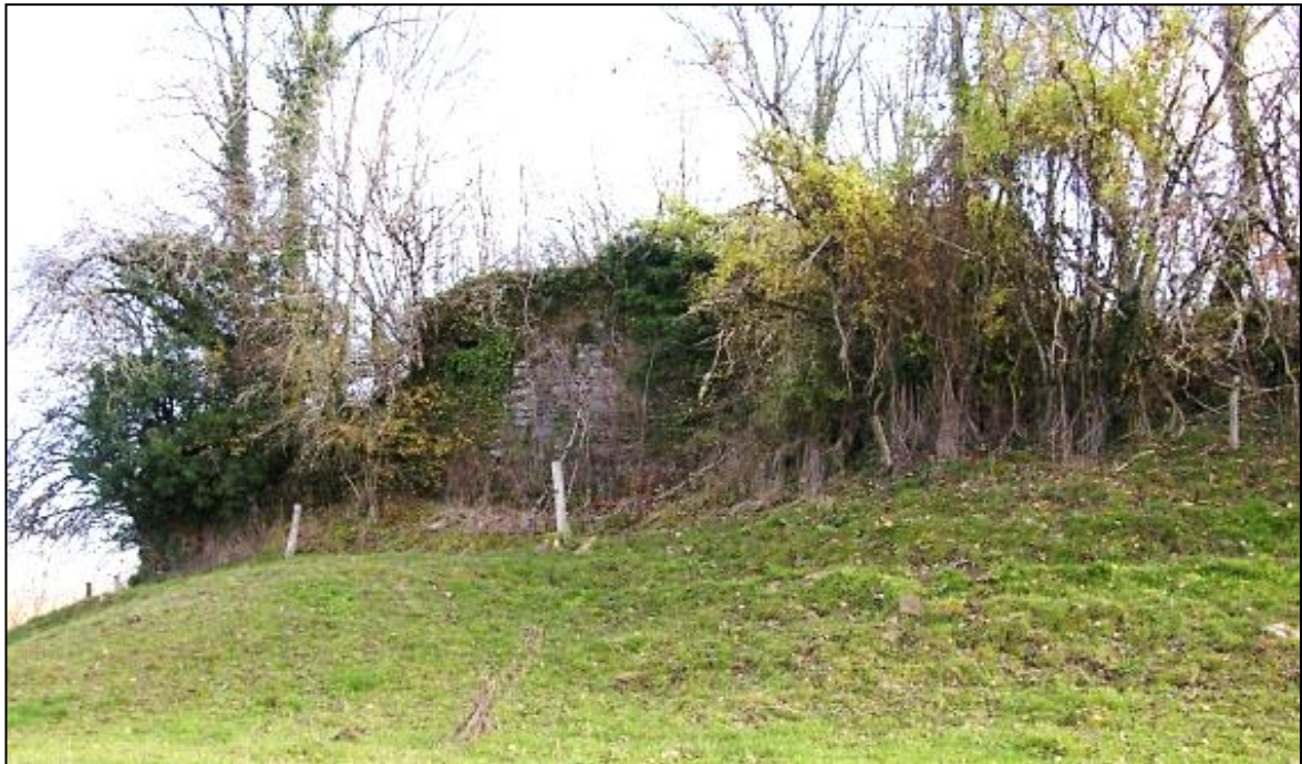
Mur ouest du château
