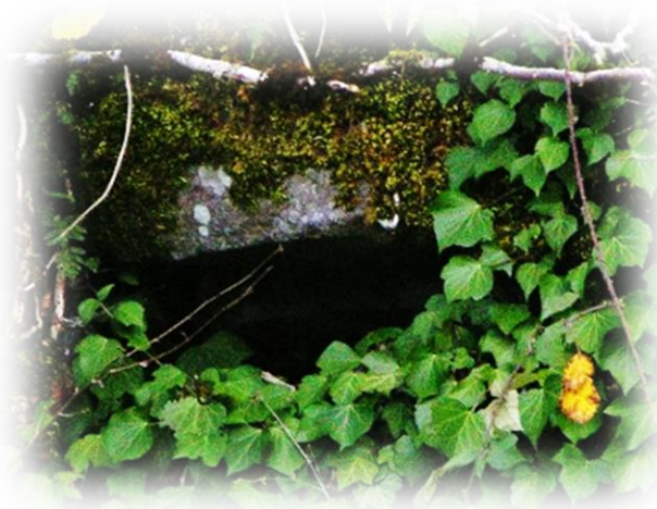
Bouche à feu Mur Ouest
