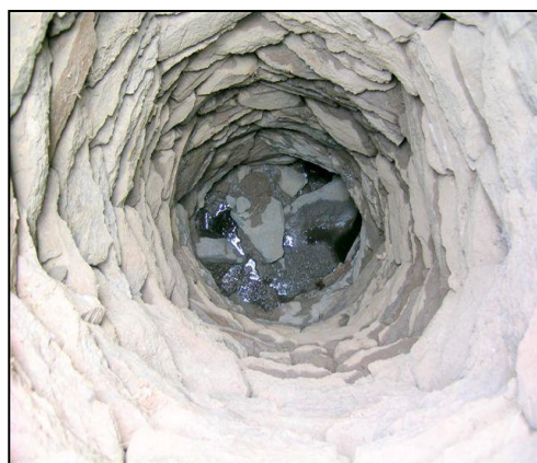
Puits de visite, cliché H. Pigeyre
