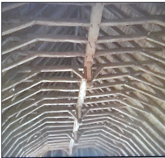
Exceptionnelle charpente à chevrons formant ferme et poinçons datée de 1773 à Saint-Julien-au-Bois (Corrèze)
