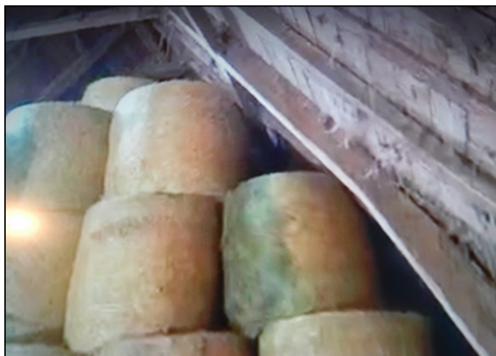
Grange de Barriac arbalétrier courbe (le cliché met bien en évidence l'intérêt de cette technique pour augmenter la capacité de stockage des bâtiments agricoles grâce à l'absence d'entrait)
