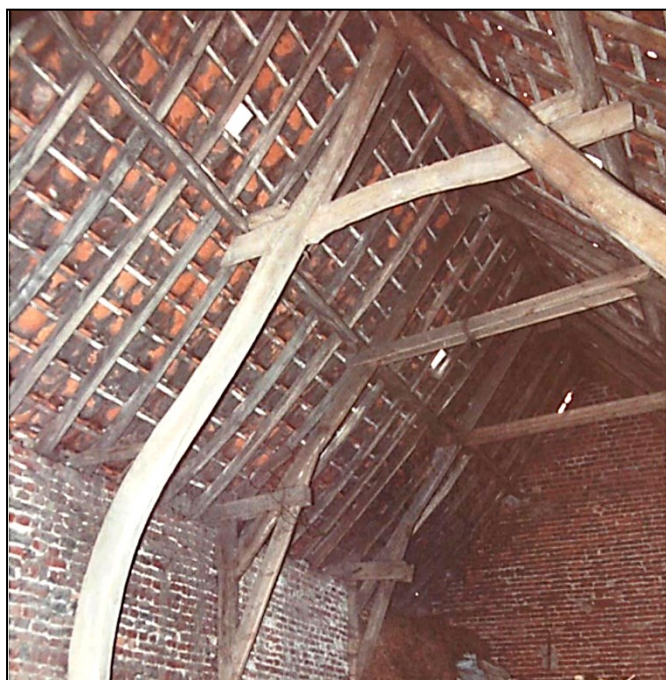
Charpente à crucks de Néchin avec un cruck au premier plan et au second plan une ferme sur poteau avec blochets
