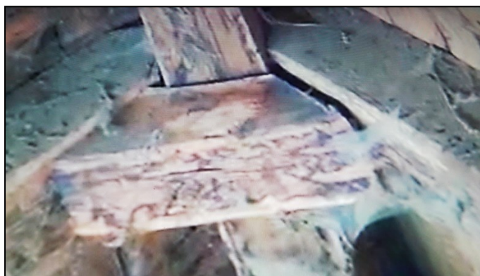
Grange de Barriac assemblage des deux arbalétriers courbes, du « joug » et de la panne faitière
