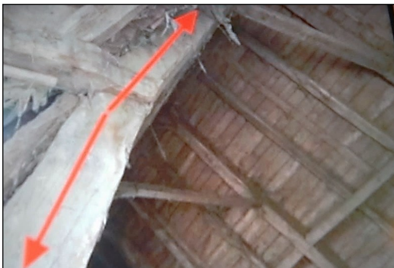
Grange de Barriac arbalétrier courbe
