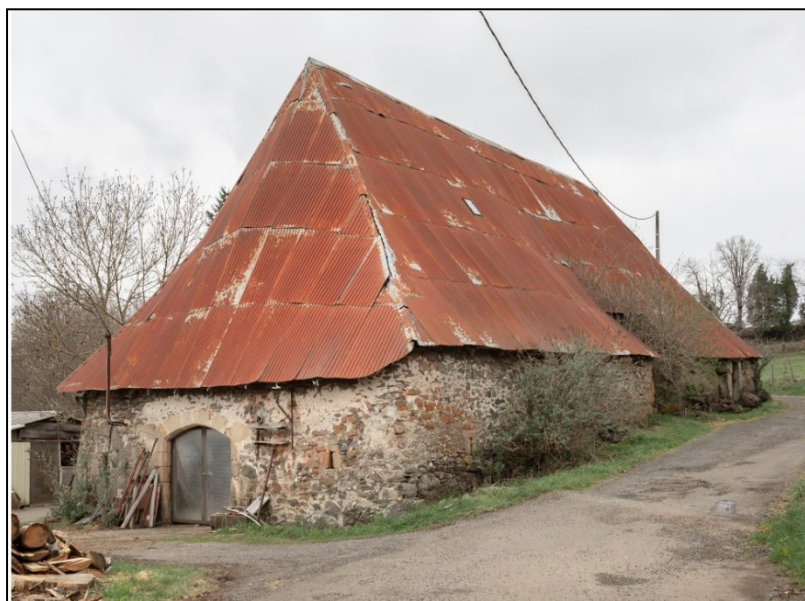
Arnac (canton de Laroquebrou) exemple de charpente à crucks et en arêtes de poisson
