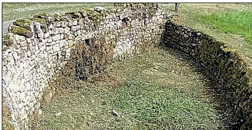
Ancienne "serve" à Saint Pierre sur Maronne . On aperçoit l'orifice des deux canaux d'alimentation sur la paroi du mur à droite (cliché E.Lorcy)
