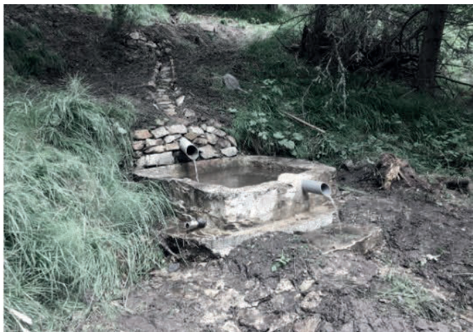
Exemple avec aménagement moderne (tuyaux en plastique)
